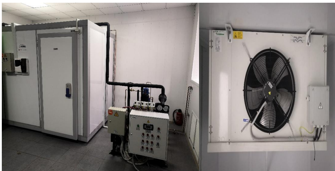
Рис 1. Низкотемпературная камера с холодильным агрегатом из трех поршневых герметичных компрессоров (а) и воздухоохладитель(б).
